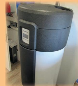
W armwasser-Wärmepumpe: regenerative Energiequelle für die Warmwasserversorgung
