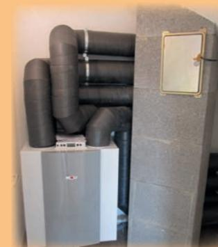
Lüftungsanlage mit Wärmerückgewinnung für saubere Luft und Energieeinsparung
