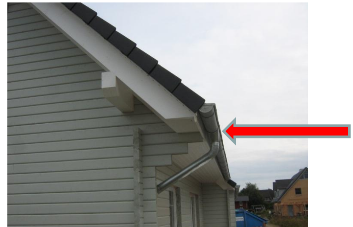
Giebelohr mit Blockbohlen-ggf. überstehende Bohlen absägen
