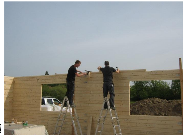
Bohle verdreht? Dann mit Schraubzwinge nachhelfen!
