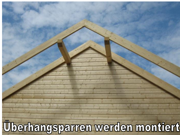
Dach wird gerichtet
